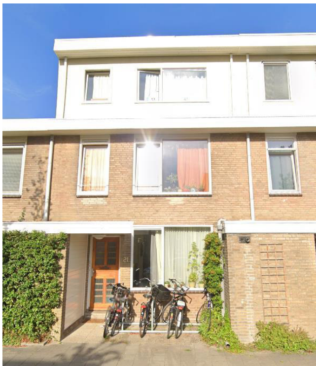
Figuur 20 Aanzicht van de woning
