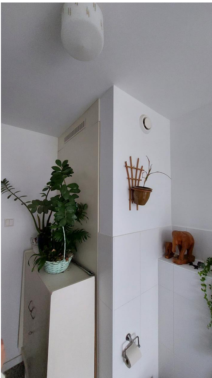
Figuur 21 Ruimte waar de cv-ketel in zit
