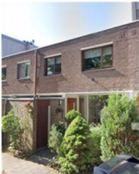
Figuur 2 Aanzicht van de woning
