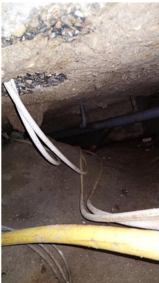
Figuur 11 Ruimte onder de vloer
