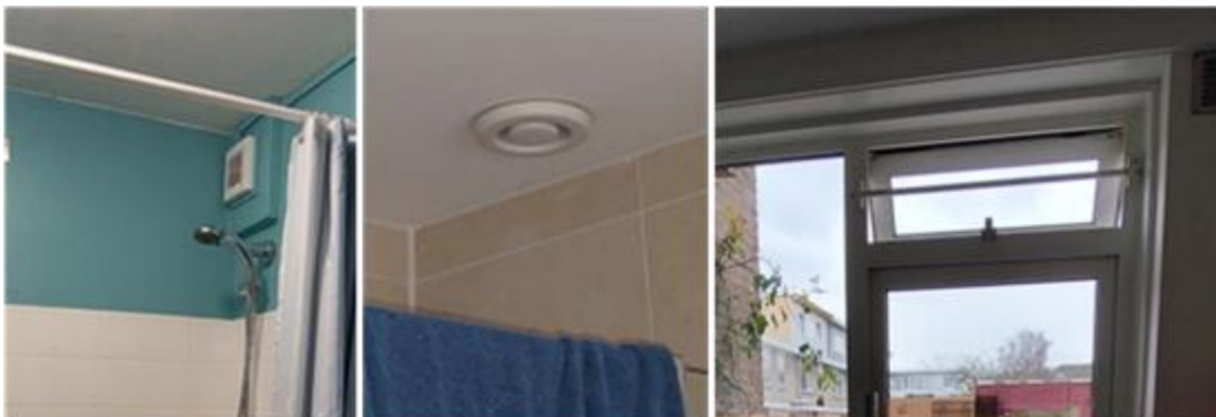
Figuur 10 Links: mechanische afzuiging, midden: natuurlijke ventilatie, rechts: ventilatie met openstaand raam
