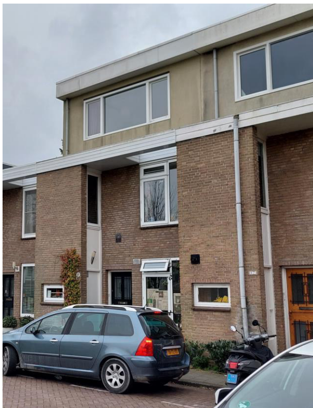
Figuur 7 Aanzicht van de woning
