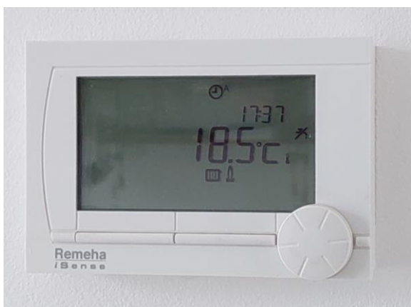
Figuur 22 Kamerthermostaat
