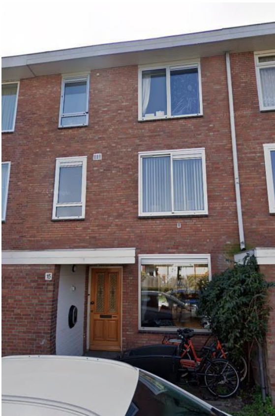
Figuur 13 Aanzicht van de woning
