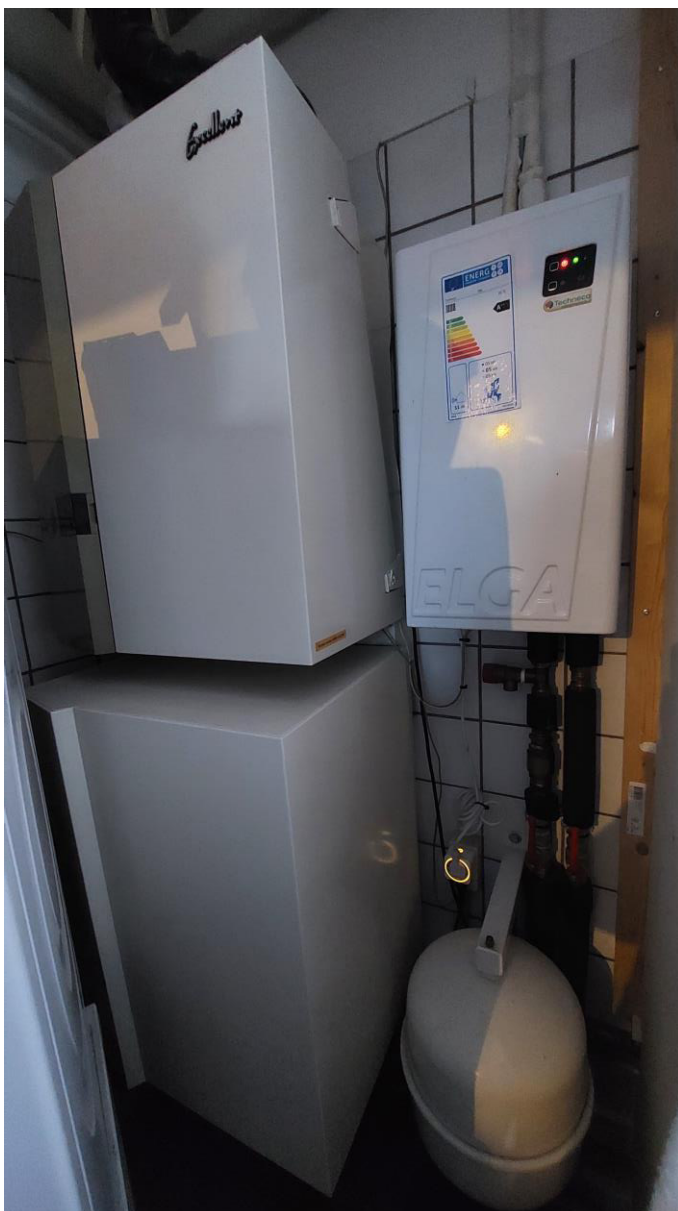
Figuur 14 Hybride warmtepomp
