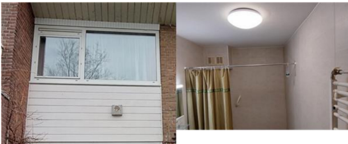
Figuur 5 Ventilatioorosters
